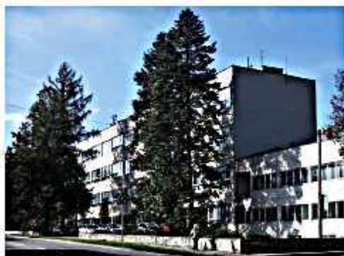
Současná budova gymnázia (2016).
