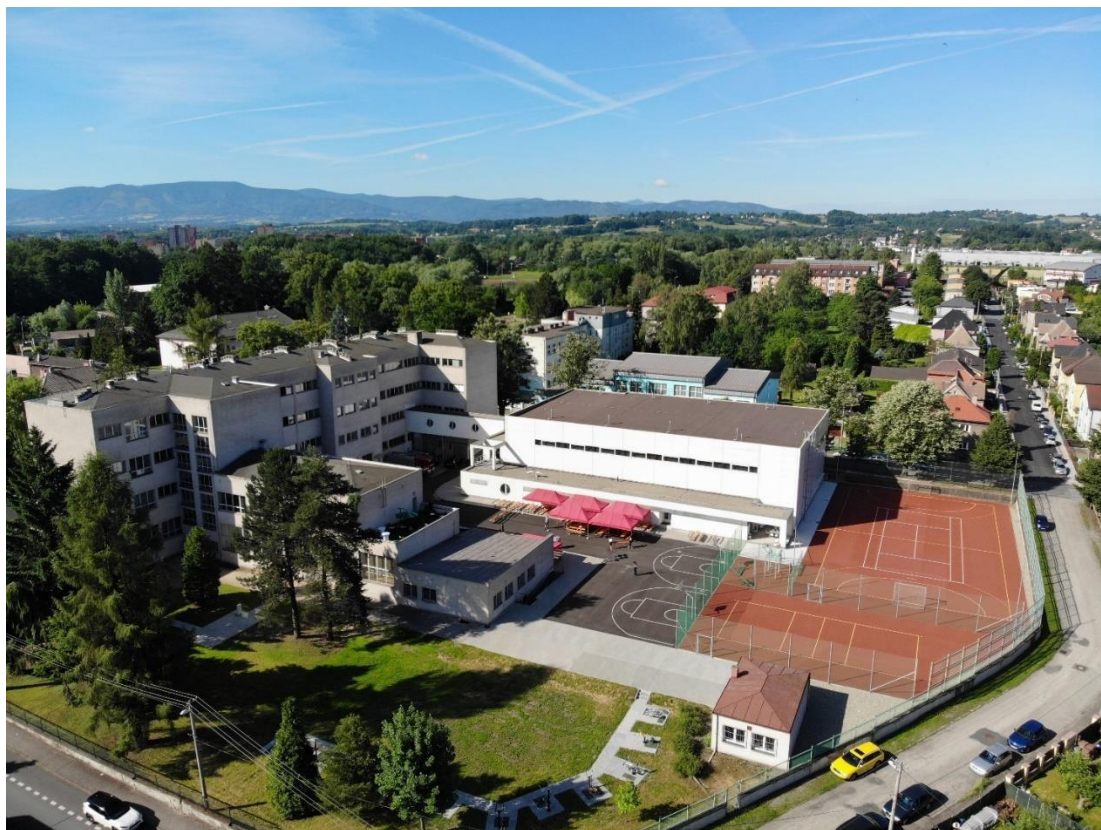
Budova školy se sportovním areálem
