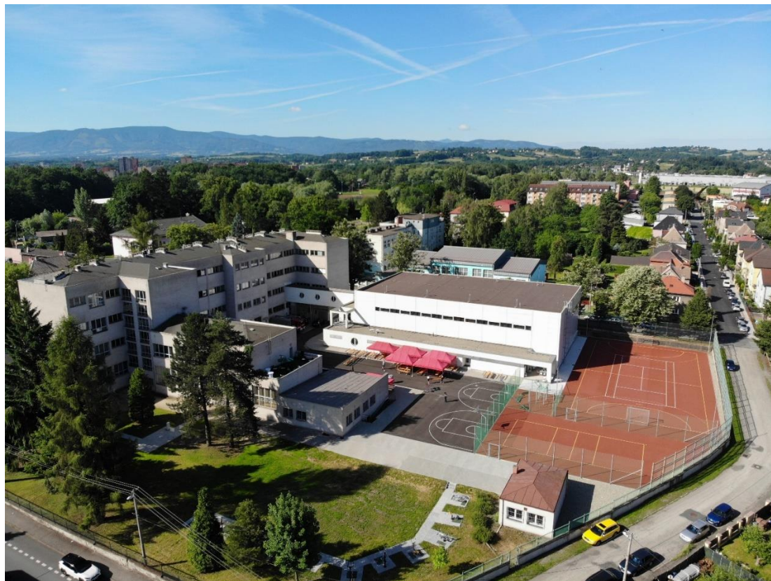
Budova školy se sportovním areálem
